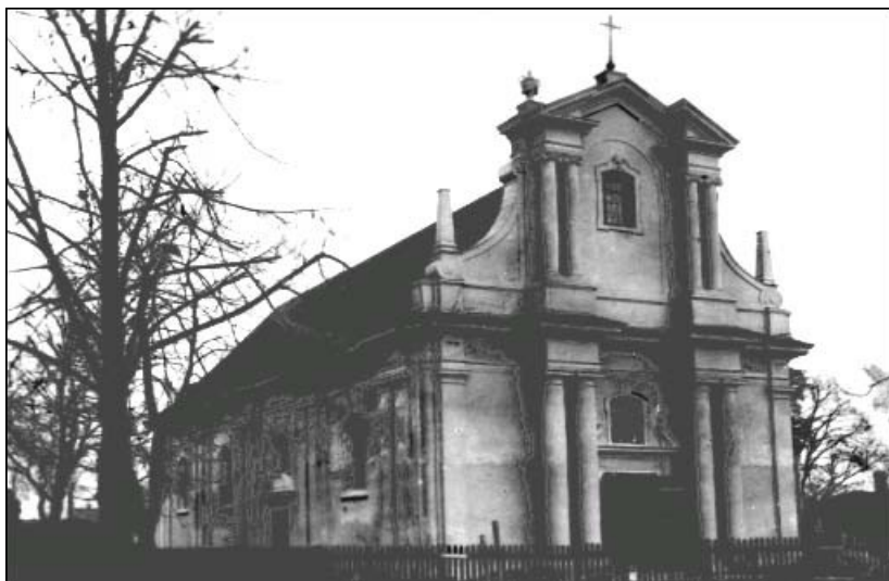
Nowy kościół w trakcie budowy jeszcze bez wieży (1929 r.)
