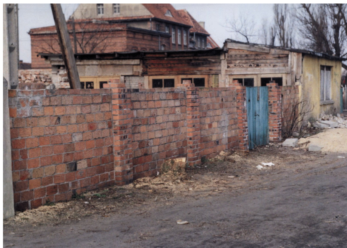
Parkan z cegły przy ul. Kościelnej. W głębi widać garaże stojące przy ul. Pielęgniarskiej.
