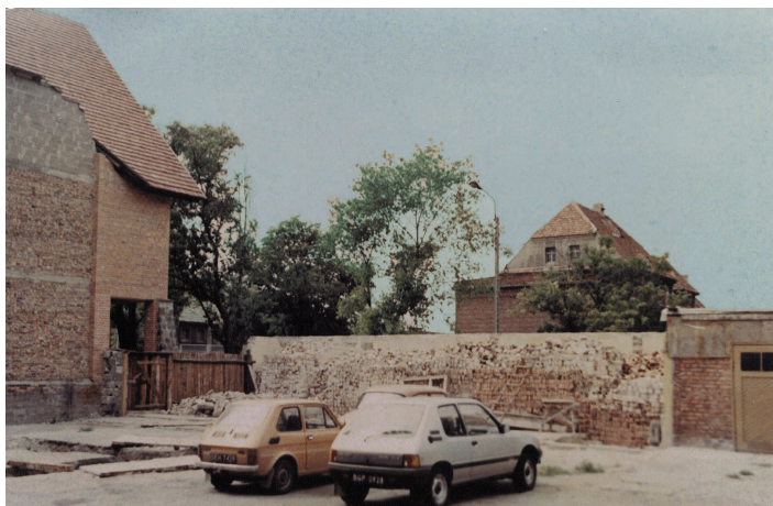
Teren przed plebanią. Widoczna pierwsza część domu katechetycznego. Z prawej strony (od ul. Pielęgniarskiej) widoczny parkan z cegły i część garaży.
