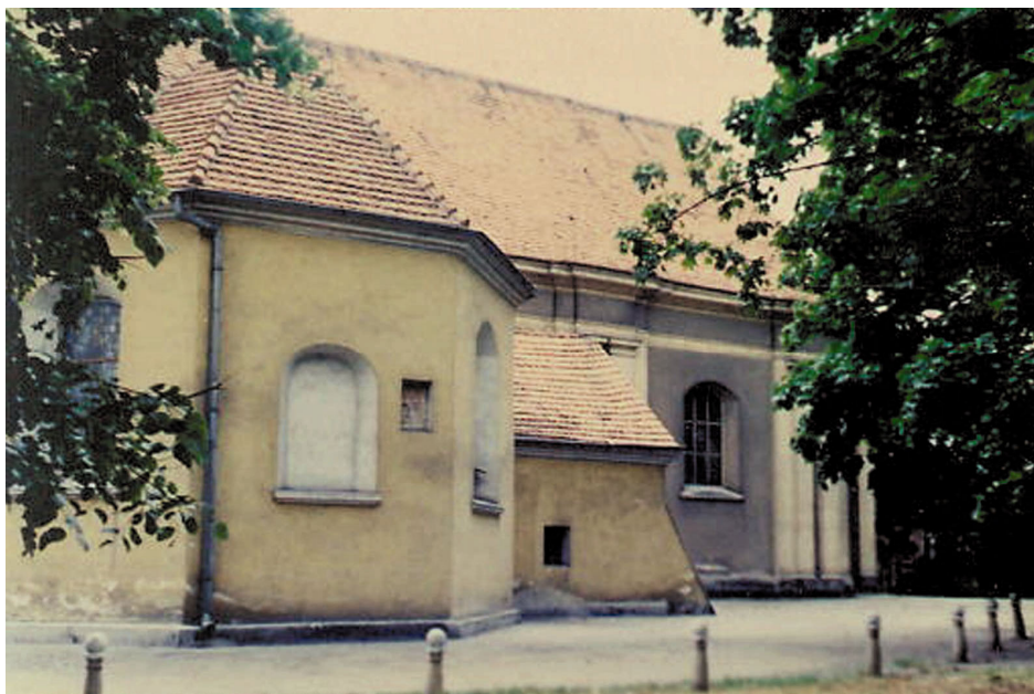
Widok na kościół i teren przed kościołem od strony zakrystii.
