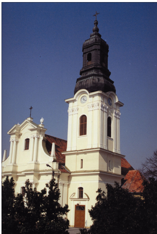
Po odnowieniu i zainstalowaniu zegara.
