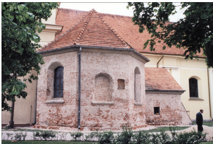
Mury kaplicy po usunięciu tynku
