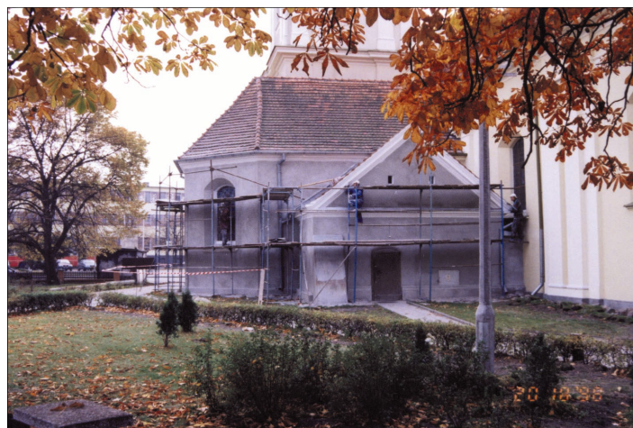
Na ściany kaplicy nałożono potrójną warstwę tynku renowacyjnego
