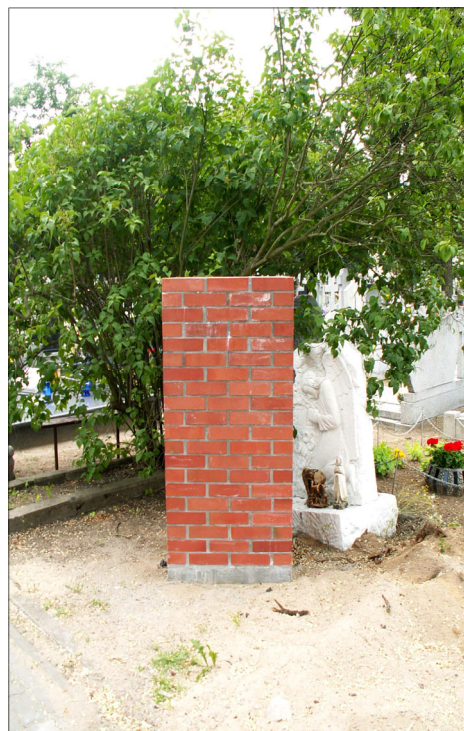
Cokół, na którym będzie umieszczona figura Matki Bożej Bolesnej.
