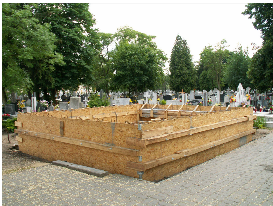
Grobowiec – w trakcie budowy.
