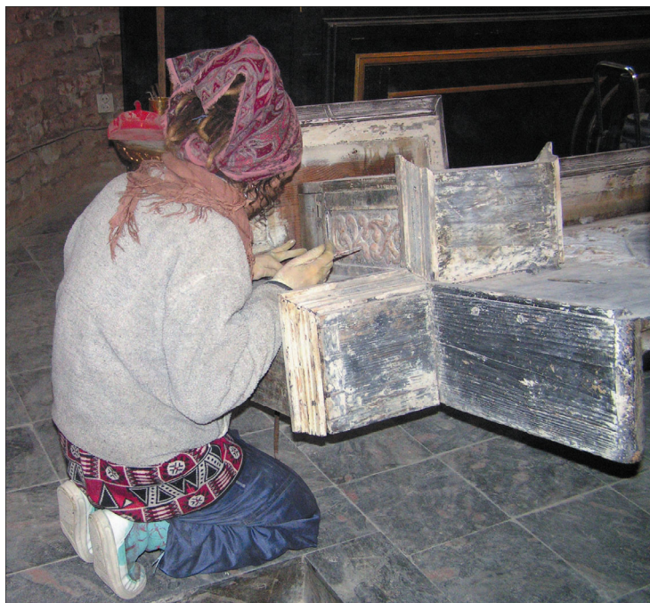
Zakładanie kitów pod złączenie, na elementach snycerskich gzymsu.
