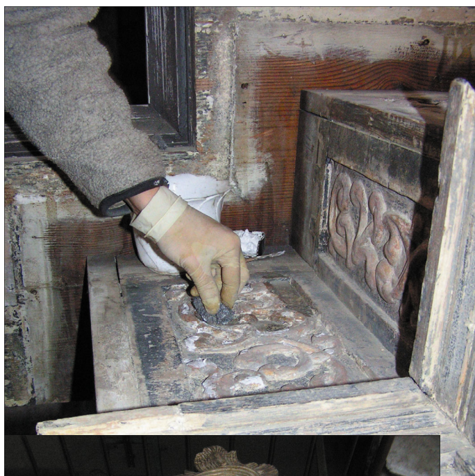
Zakładanie kitów pod złączenie, na elementach snycerskich gzymsu.
