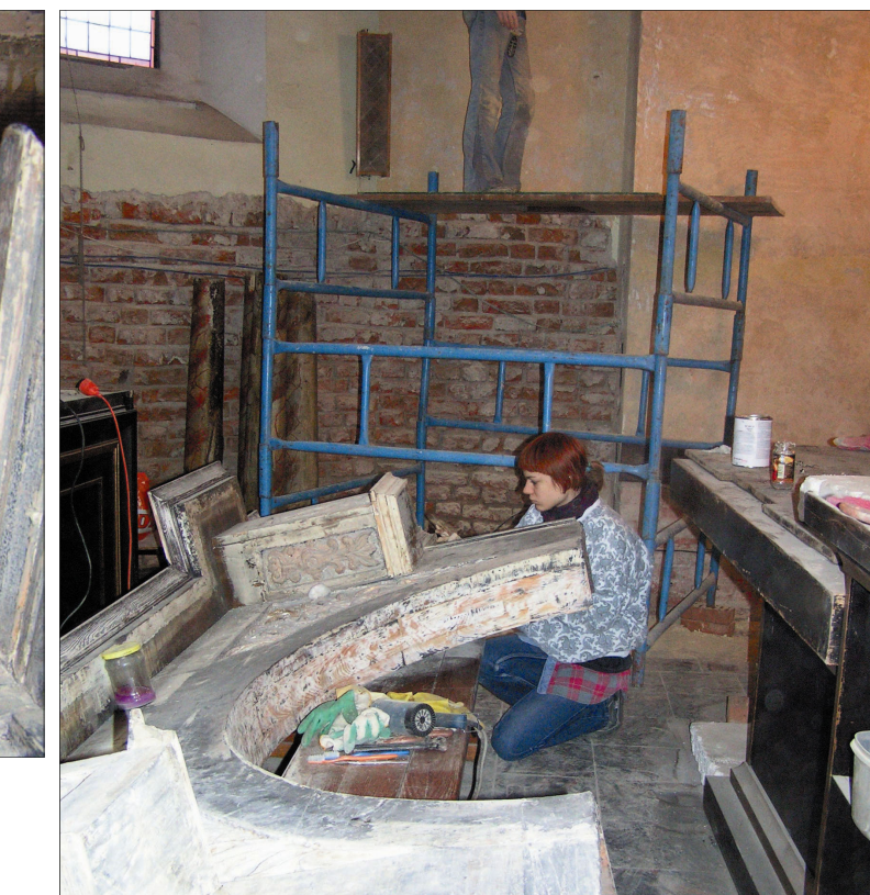
Zakładanie kitów wyrównujących zaprawę pod złączenie, na gzymsie ołtarzowym.
