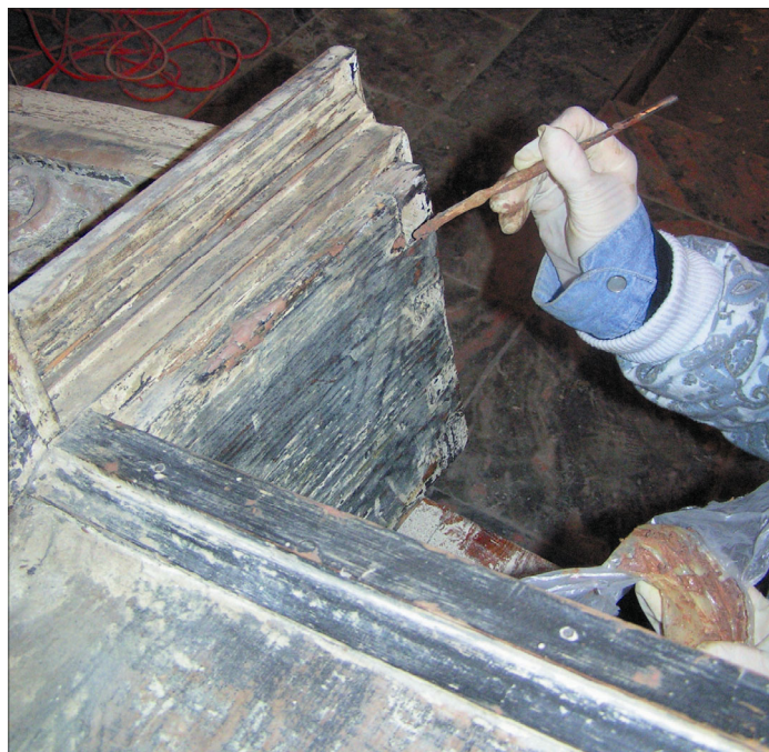
Uzupełnianie ubytków w drewnie, na gzymsie ołtarza kitem epoksydowym.
