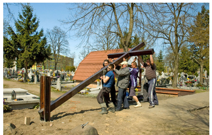
Montaż krzyża na cmentarzu parafialnym.
