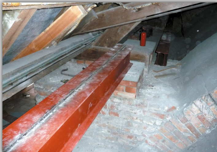
Belka stalowa na podporze
