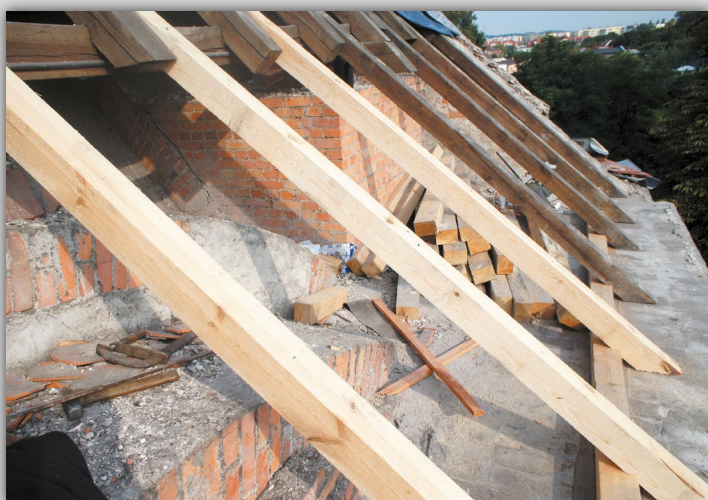
Wymienione krokwie dachowe
