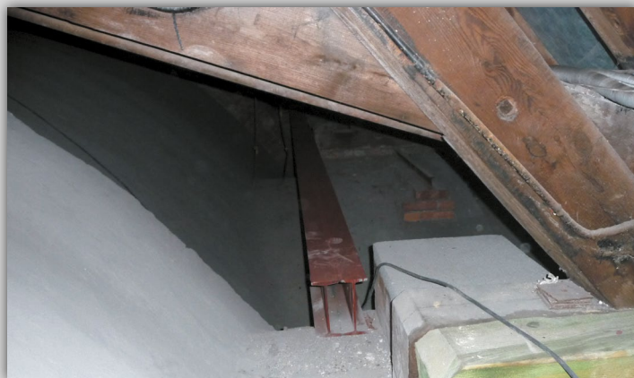
Przygotowana belka stalowa
