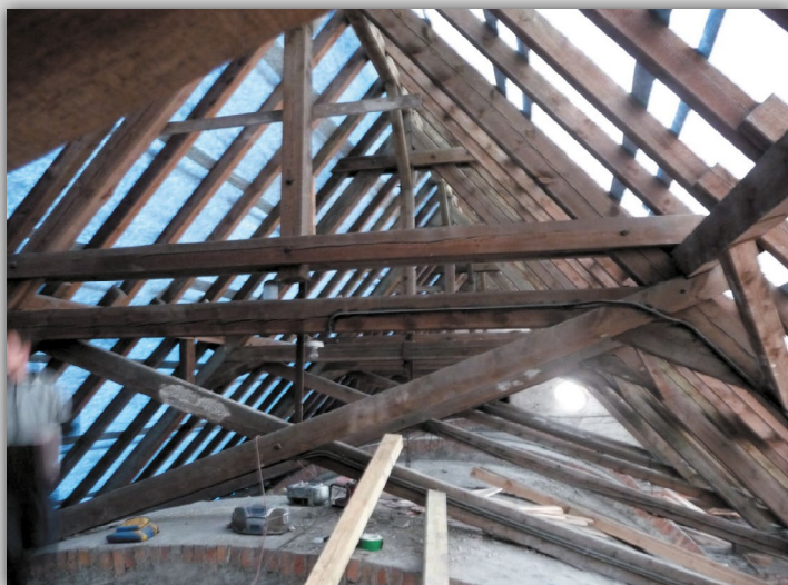
Konstrukcja dachu w trakcie impregnacji
